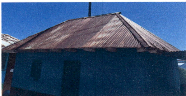
Foto 3: Cocina: desinstalación de lámina existente; sustitución de lámina, por lámina troquelada aluzinc calibre 26 e instalación de canales.
