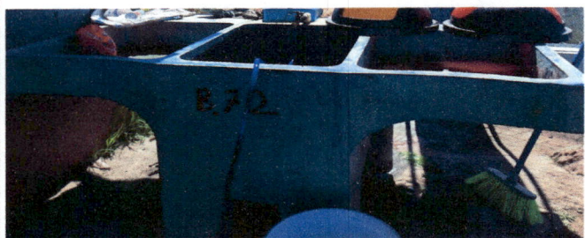
Foto 5: sustitución de pila de cemento de dos lavaderos
